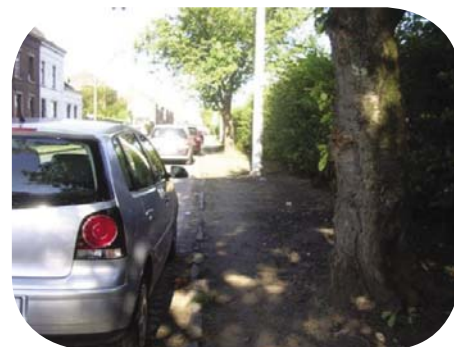
Trottoir en mauvais état
