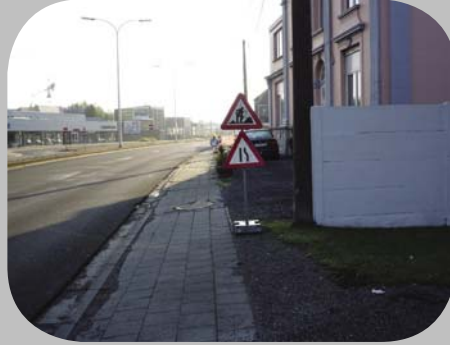
Trottoir en mauvaise condition et pente dangereuse
